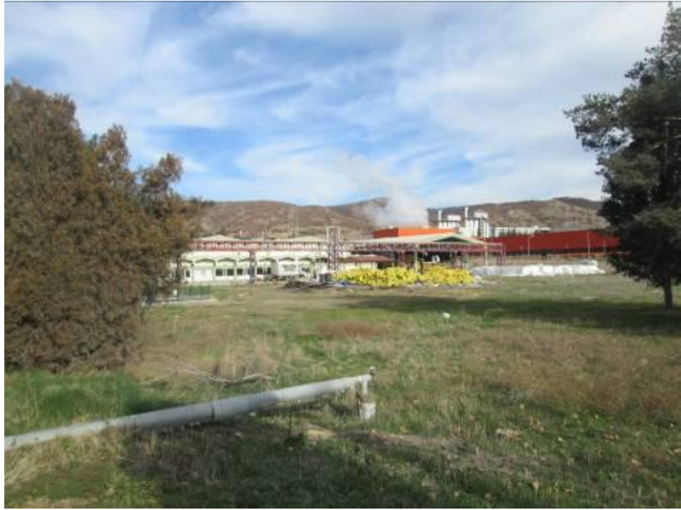
İşletme binası-sevkiyat ambarı
